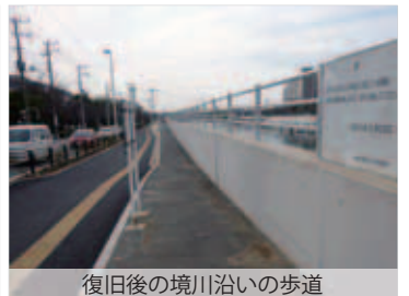
復旧後の境川沿いの歩道
