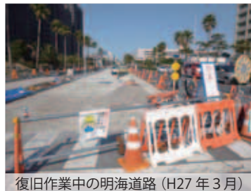
復旧作業中の明海道路 (H27年3月)
