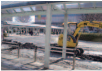
復旧作業中の新浦安駅南口ロータリー
