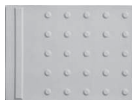
■内方線付き点状ブロック
